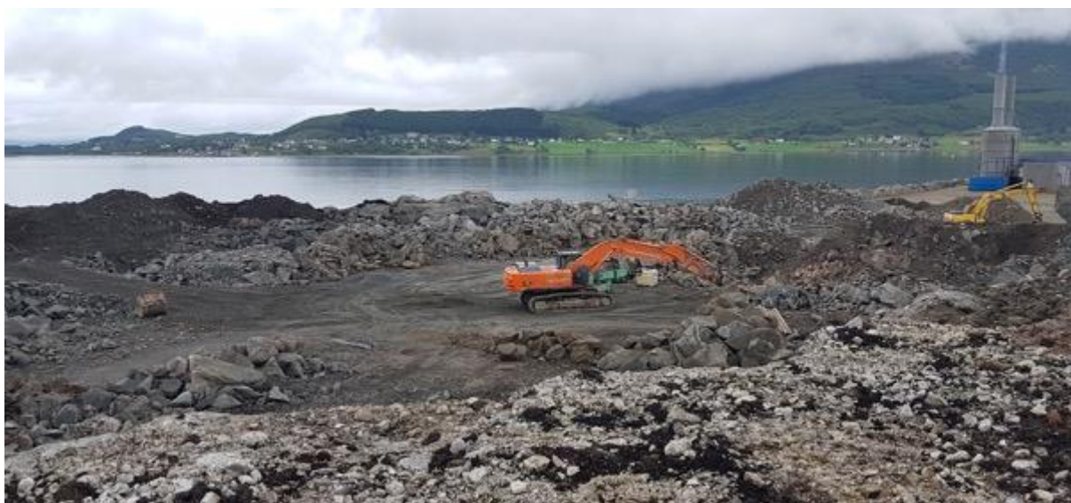
Uttak av masser innenfor B11 er nesten ferdig.
