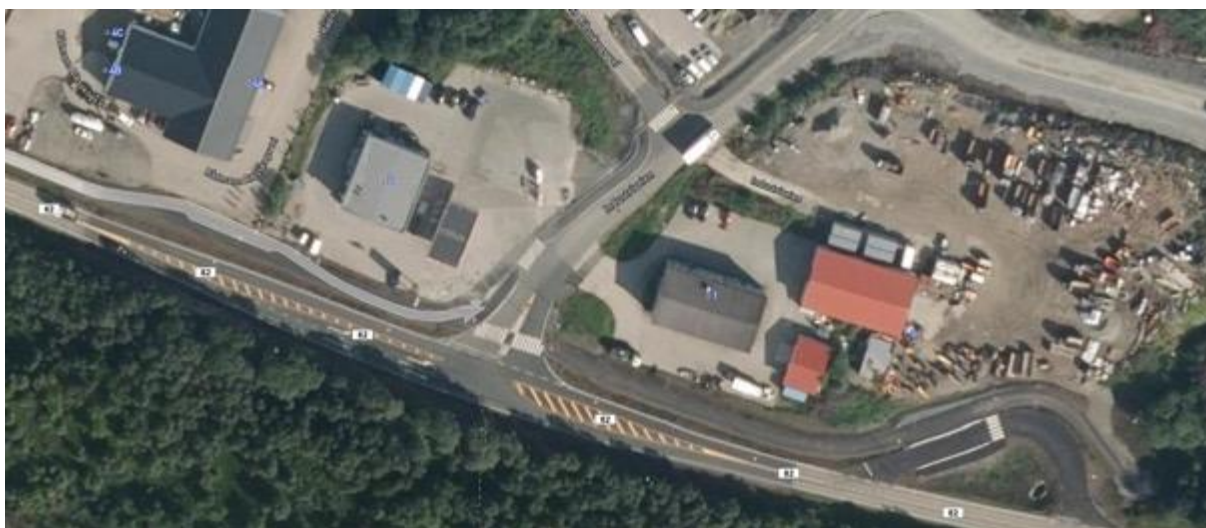
Nytt kryss rv.82/Industriveien. Bussholdeplass ved Rv.82 på høyre side av bildet.
